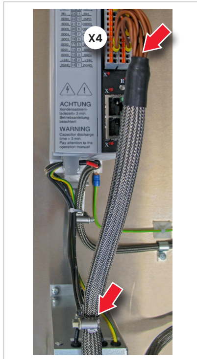
Abbildung 18.2 Musteraufbau - Detail 4: Steuerleitungen
