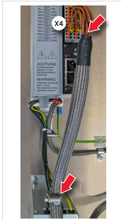
Abbildung 18.2 Musteraufbau - Detail 4: Steuerleitungen
